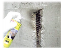
露出鉄筋への防錆施工
